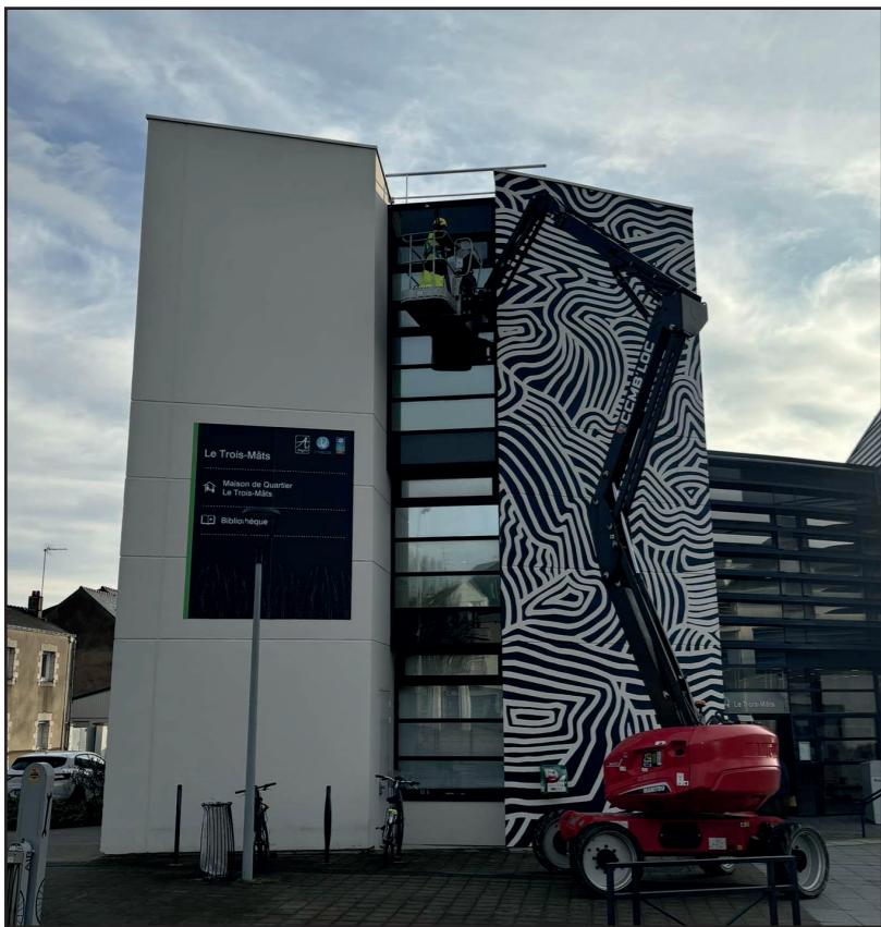
Avec l'utilisation d'une nacelle diesel articulée nous avons effectué un remplacement d'un double vitrage clair feuilleté en partie haute de la cage d'escalier.
